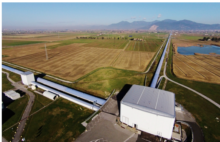
Fig. 6.2 Edificio centrale, mode cleaner e braccio Nord di Virgo.
